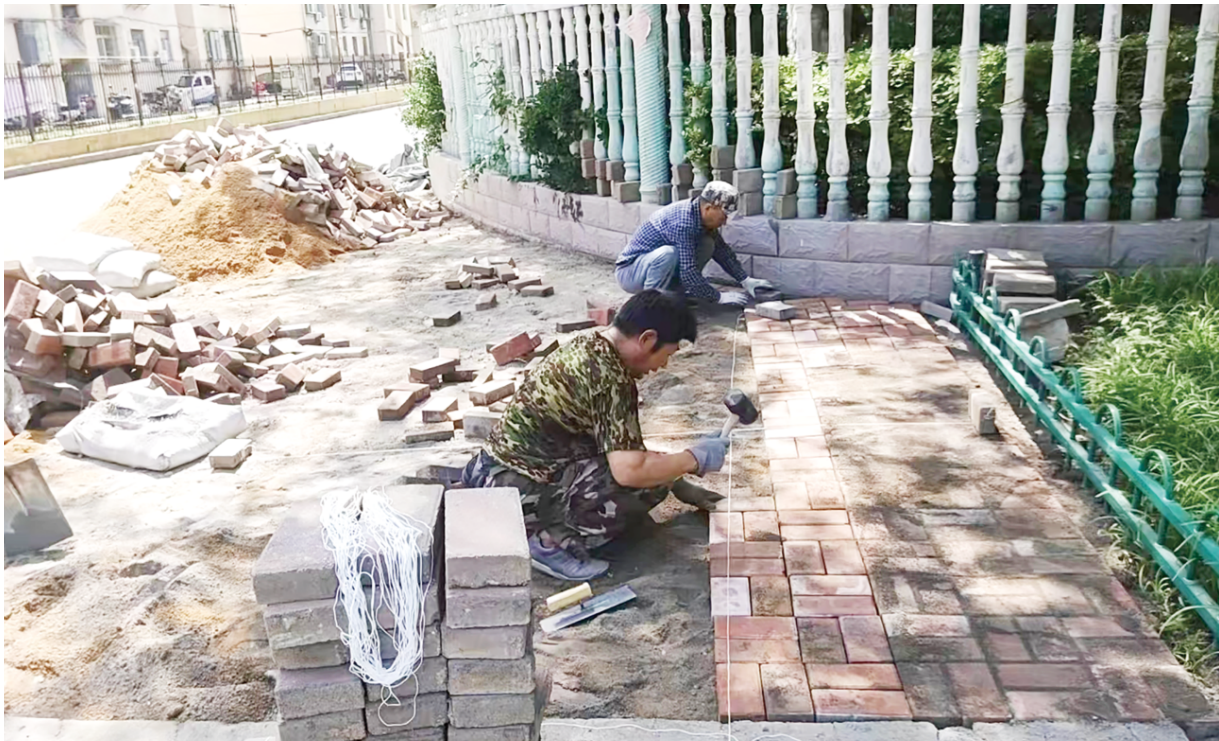
施工人员维修新华甲巷的破损路面。
