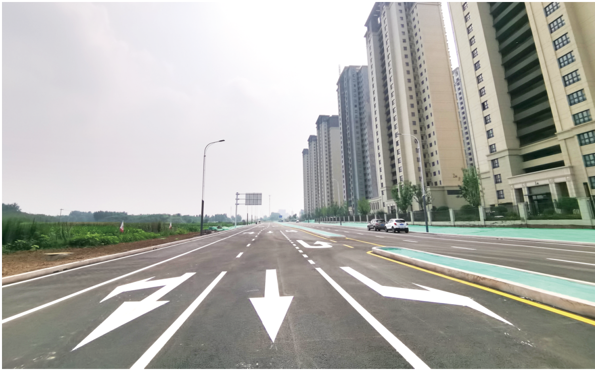
潍城区乐川西街(清平路—友爱路)新铺路面宽阔平整。
