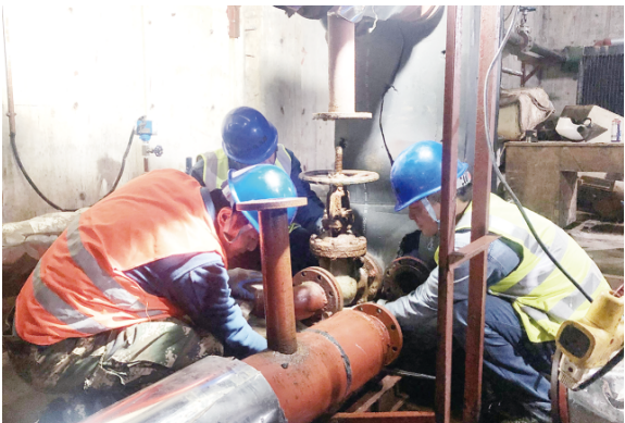
供热企业对老旧小区供热设施进行改造提升。
