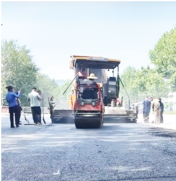
施工人员重铺沥青路面。（视频截图）
