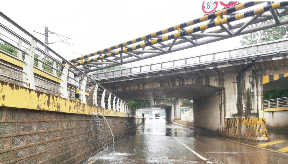
潍州路铁路桥下几乎没有积水,车辆有序通行。
