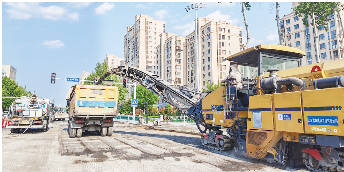
玉清东街北海路至虞河路路段已经启动路面整修。
