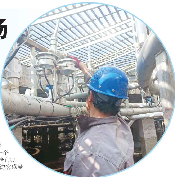
工作人员对音乐喷泉设施开展维护保养。
