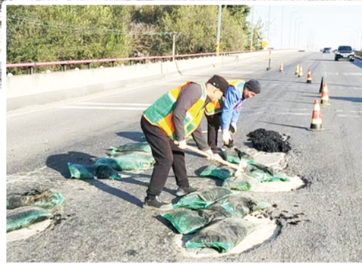
施工人员对路面进行维修。
