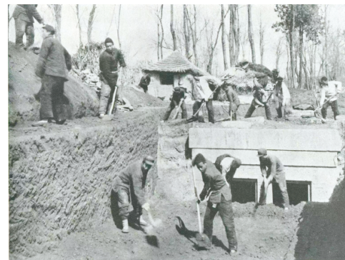
沂南汉墓发掘现场,清理墓门和墓顶的填土。
