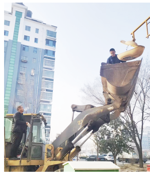
工作人员维修小区路灯。
