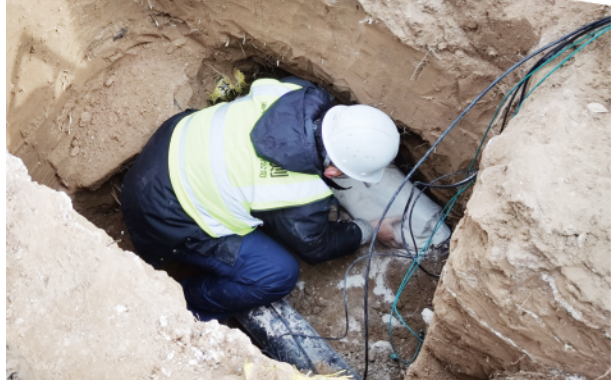
施工人员安装“阴极保护测试桩”、埋设“阳极包”。
