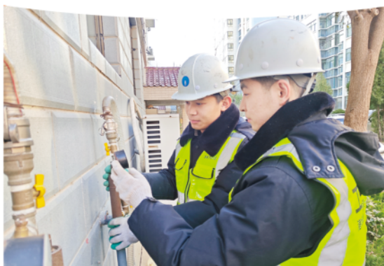
施工人员更换“新型绝缘活接”。
