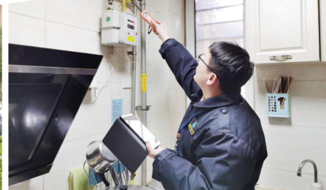
安检人员对居民家里的燃气设施进行安全检查。
