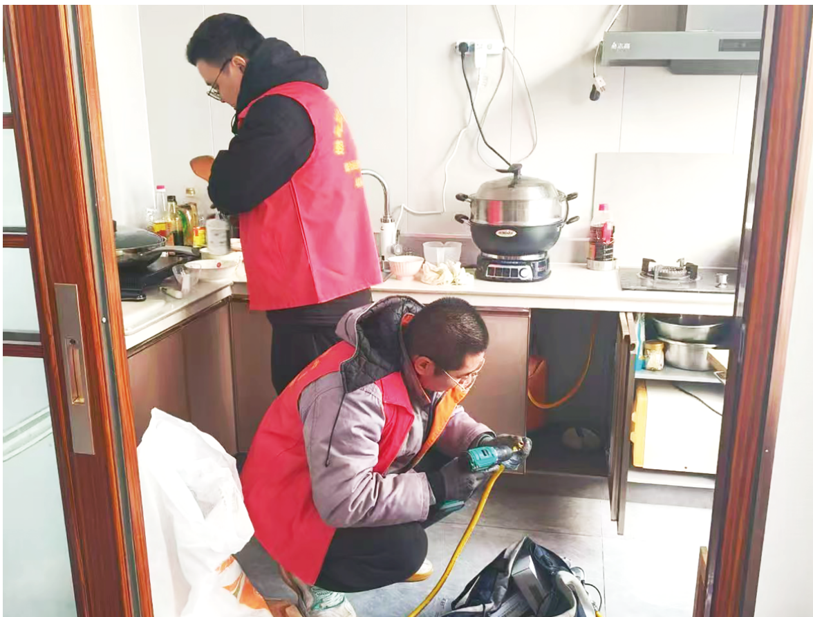
专业人员在居民家中免费安装燃气“四件套”。
