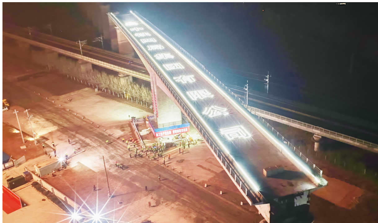
潍宿高铁首个跨高速铁路转体梁正在转体。
