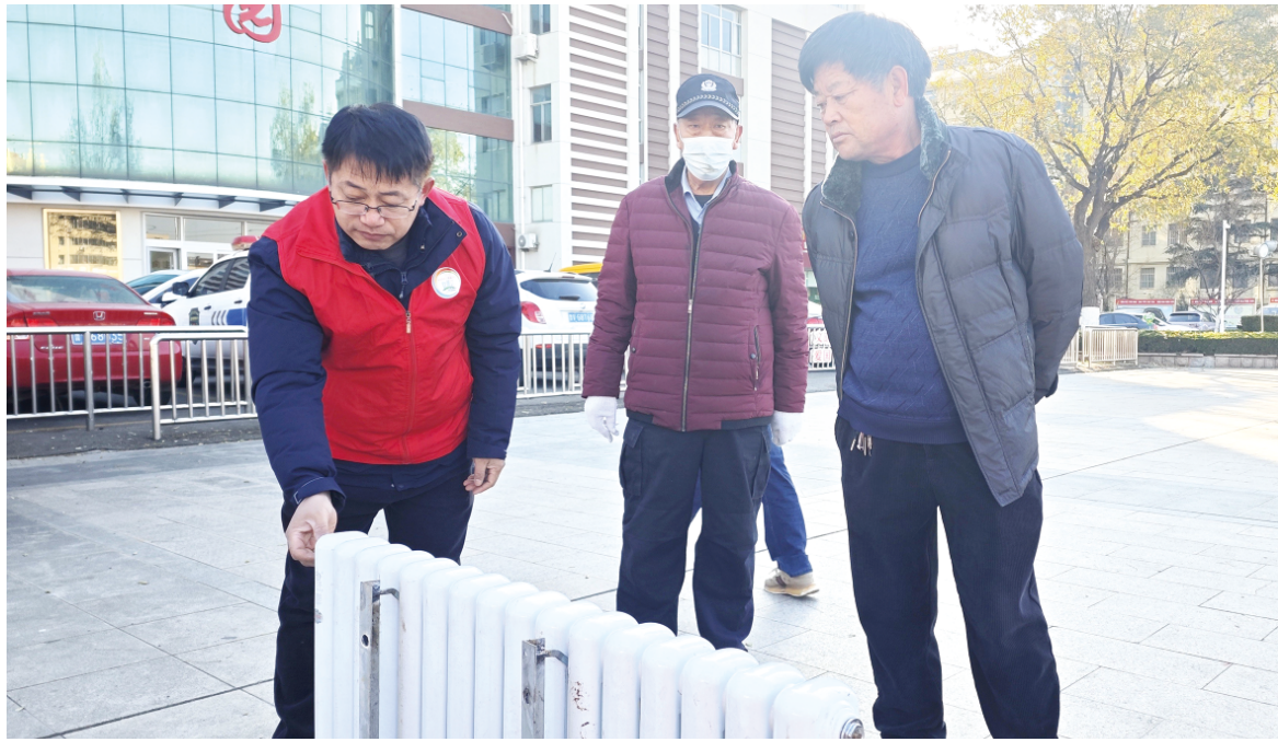
热企工作人员现场演示暖气片“排气”方法。
