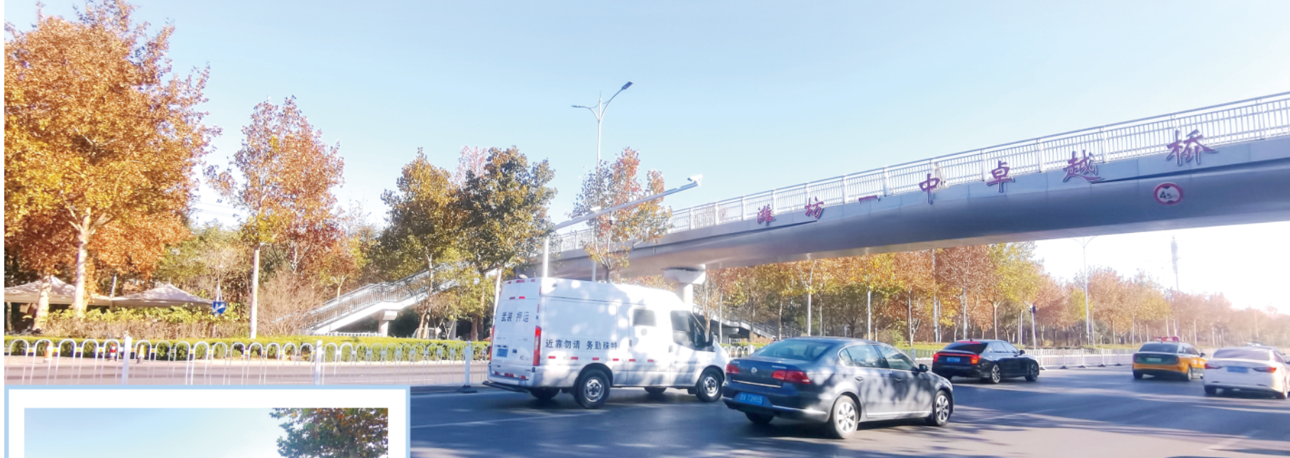
潍坊一中卓越桥投用后，道路通行效率大幅提高。
