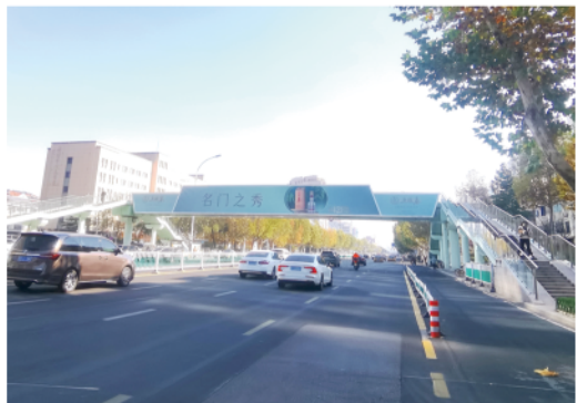
位于东风东街与文化路交叉口西侧的过街天桥
