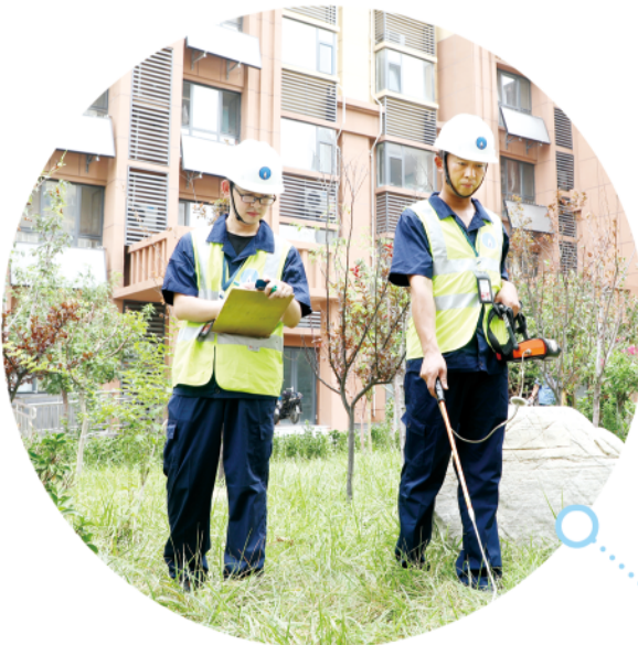
巡检队伍巡查燃气管线及调压设备。
