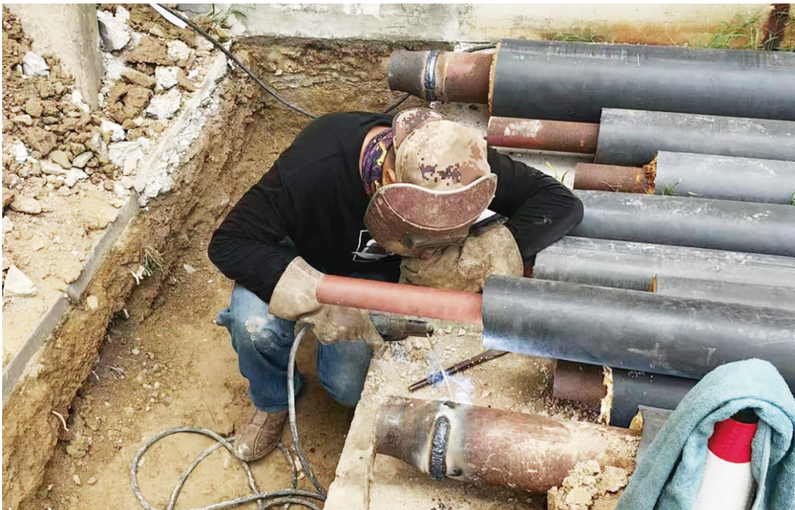
中心城区一小区进行供热设施改造(资料图)。
