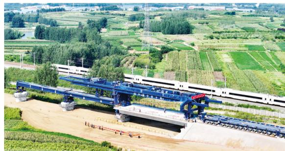
8月22日,在潍宿高铁至青岛连接线1标段沙河中村特大桥施工现场,中铁十局的工作人员进行箱梁架设作业(无人机照片)。8月22日,潍(坊)宿(迁)高铁至青岛连接线1标段首榀箱梁架设成功,标志着潍宿高铁至青岛连接线全部4个标段进入全线架梁施工阶段。据悉,潍宿高铁至青岛连接线东起青岛,经潍坊诸城市、日照五莲县与新建潍宿高铁相连。项目建成后,将对山东半岛城市群互联互通和环渤海经济发展等起到重要推动作用。 新华社发
