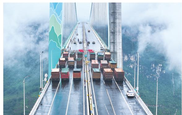
8月21日拍摄的贵州花江峡谷大桥荷载试验现场(无人机照片)。8月21日，在建世界第一高桥——贵州花江峡谷大桥正式启动荷载试验。2022年开工建设的花江峡谷大桥，跨越被誉为“地球裂缝”的花江大峡谷，是贵州省六枝至安龙高速公路的控制性工程。大桥为钢桁梁悬索桥，全长2890米，其中主桥跨径1420米，桥面至水面高度625米。 新华社发
