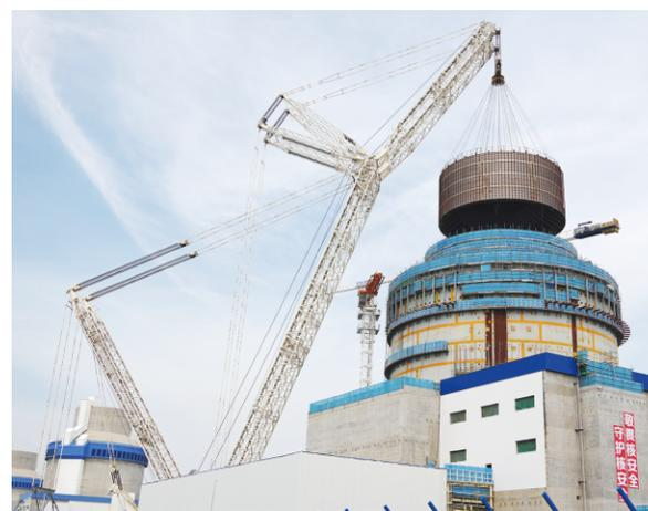
这是8月4日拍摄的山东海阳核电3号机组核岛CB20模块吊装现场。当日,国家电投山东海阳核电站3号机组核岛CB20模块顺利吊装就位,标志着该机组大型模块全部吊装完成,开始进入设备安装调试阶段。据了解,建设中的海阳核电3、4号机组是国家“十四五”规划重点项目,计划2027年全面投运。 新华社发
