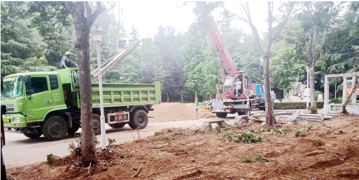
工人在现场加紧施工。
