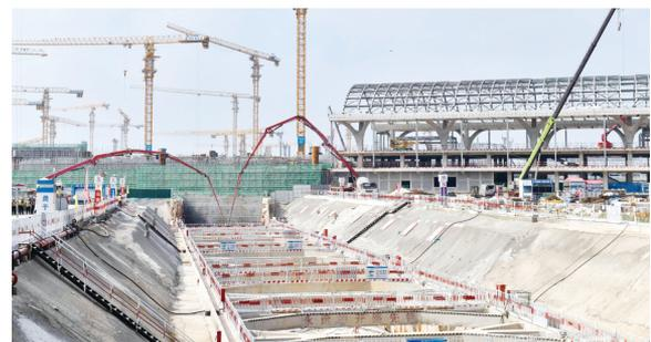
7月30日拍摄的济滨高铁机场隧道施工现场。当日，济（南）滨（州）高铁机场隧道贯通。济滨高铁机场隧道是济滨高铁的控制性工程，采用地下明挖法施工，全长2710米。据悉，济滨高铁是津潍高铁通道及山东省快速铁路网鲁北通道的重要组成部分，是国家铁路网“八纵八横”快速通道主骨架京沪、青太通道的重要联络线。 新华社发
