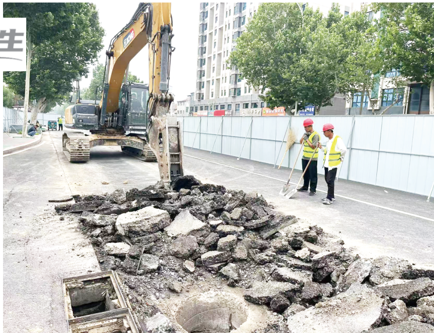
工人正对易积水路段进行施工。
