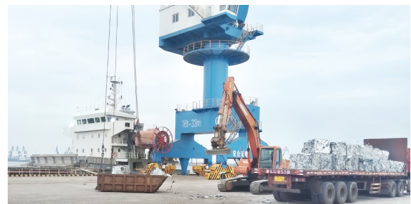
潍坊港区东作业区1#泊位在进行废钢装船作业。
