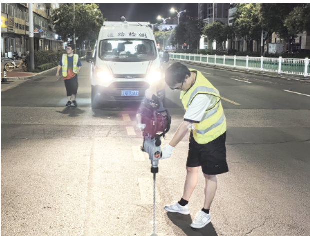
工作人员开展地下病害探测。
