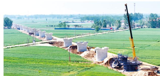
4月30日,在潍宿高铁山东东郊城段,中铁上海局的工作人员在进行墩身施工(无人机照片)。国家重点项目潍(坊)宿(迁)高速铁路项目承建方正抢抓工期与节点,稳步推进标段施工。据悉,潍宿高铁是京沪高铁辅助通道的重要组成部分,与在建的天津至潍坊高铁,已开通运营的济南至青岛高铁、徐州至盐城高铁、日照至兰考高铁相连接,区域路网地位重要。潍宿高铁建成后,将大大便利沂蒙山、苏北革命老区群众出行,对区域经济社会发展具有重要意义。 新华社发
