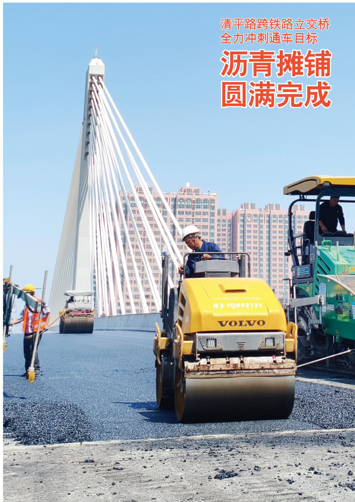
4月28日，在清平路跨铁路立交桥上，一台台压路机对摊铺好的沥青进行压实作业。当日，在潍坊市站南广场片区开发建设项目指挥部统一指挥调度下，由中铁二十一局承建的清平路跨铁路立交桥工程迎来关键节点，桥面沥青摊铺施工顺利完成，为实现通车目标奠定坚实基础。
