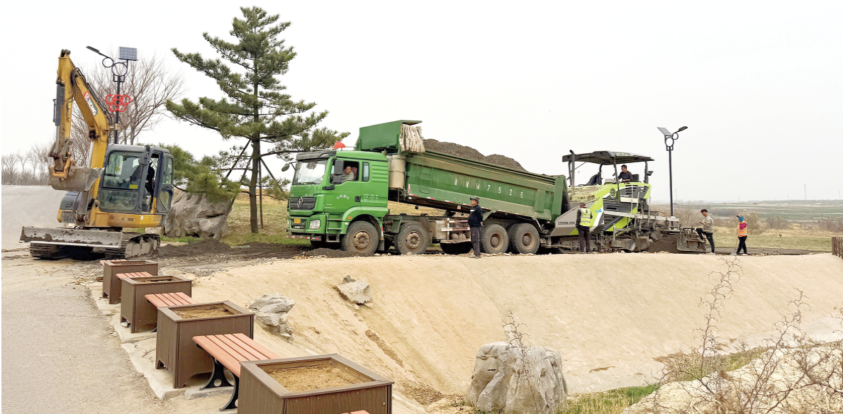
大型机械来回穿梭,施工人员正在加快推进场地修建工作。
