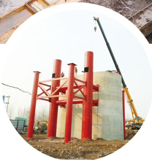
在诸城市枳沟镇高铁先行开工点，巨大的桥墩拔地而起。
