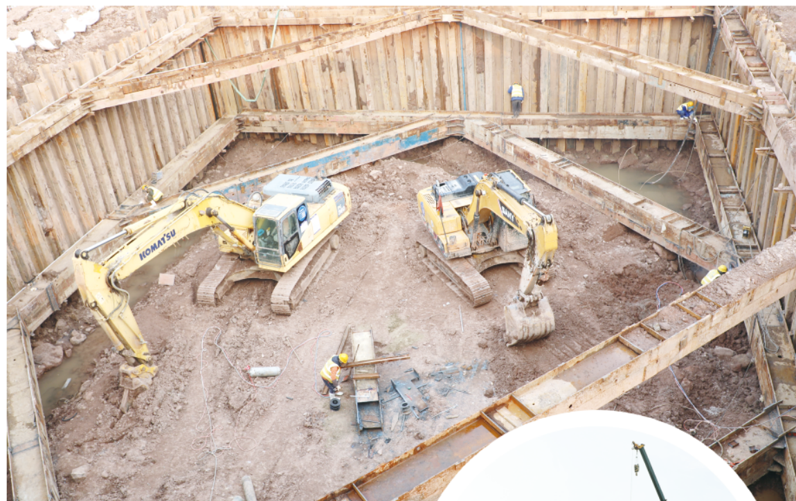
在跨潍河施工点，施工人员正在忙碌。
