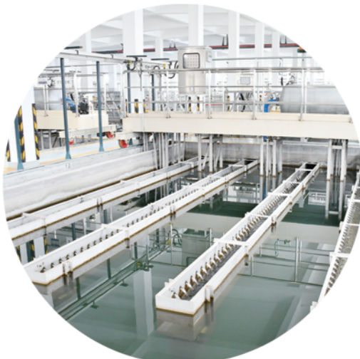
眉村净水厂新建的供水设施。
