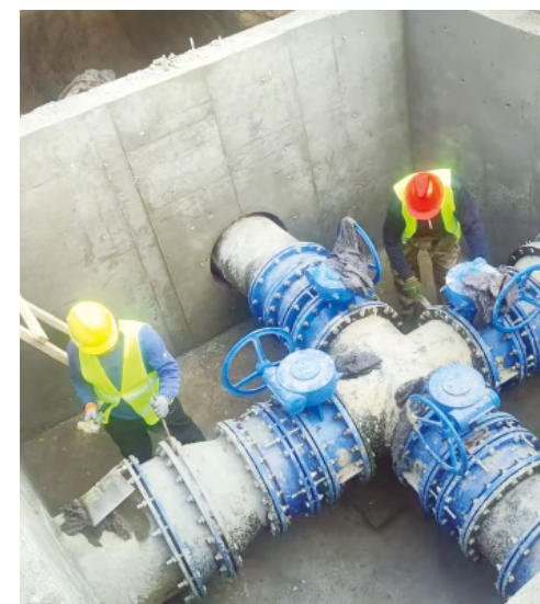
施工人员进行管道打压检查
