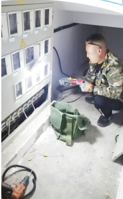
西羊角埠社区工作人员安装充电桩。
