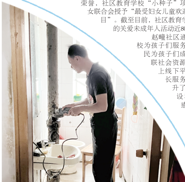
北关街道陈家油坊社区物业工作人员为居民修下水管道。
