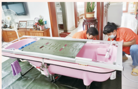
安装助浴分体式浴缸。
