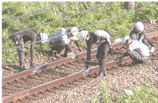
当地时间8月1日,随着酷暑持续,日本熊本县鹿儿岛本线电车轨道因气温上升而变形,停运约3小时,约15名工人用冰块冷却轨道后(上图),变形恢复正常。据九州旅客铁道称,10趟当地列车停运,1趟列车晚点,影响约2000人。
