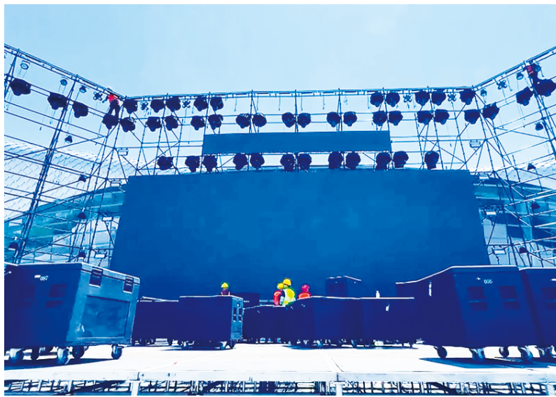
在欢聚潍坊·2024青岛啤酒畅享节筹备现场,施工人员在忙碌。
