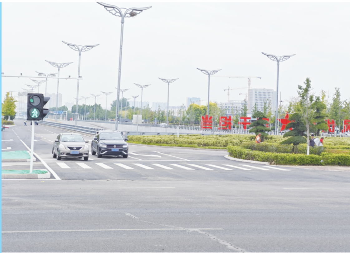
禹王街与渤海路平交口改造完成后，渤海路地面道路增加了直行和左转车道。
