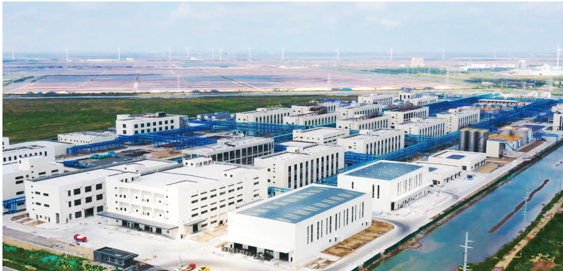
山东万盛年产55万吨功能性新材料一体化生产项目现场。(资料图片)
