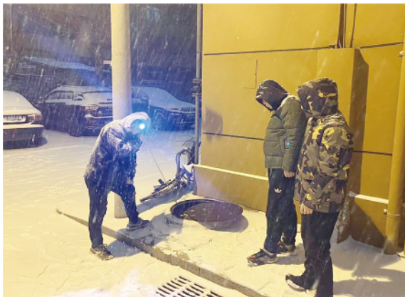
热力企业工作人员开展节前巡检。
