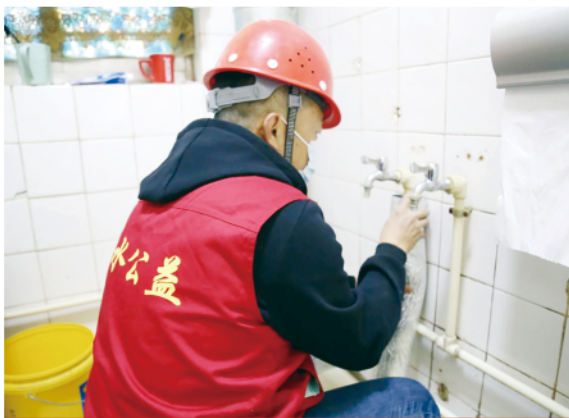
供水企业工作人员入户检查供水设施。
