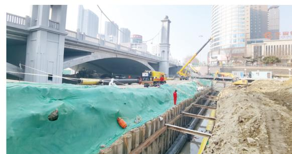
本报讯(潍坊日报社全媒体记者 赵春晖)1月12日,记者在城区东风桥北侧的白浪河河道内看到,这里挖了一条横跨白浪河两岸的深沟,施工人员正在往里铺设大口径高温水管道(上图),目前工程正在进行中。
