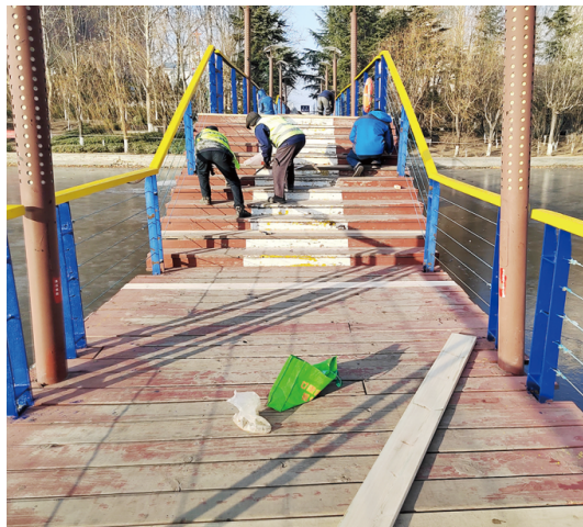
施工人员在虞河景区修复木栈道。
