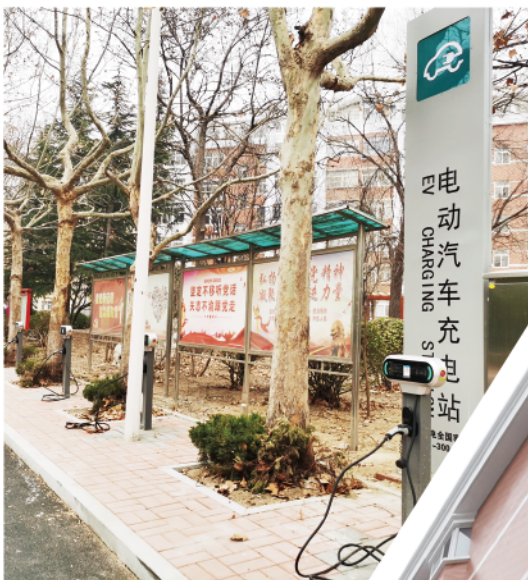
清平花园小区新建了电动汽车充电站。
