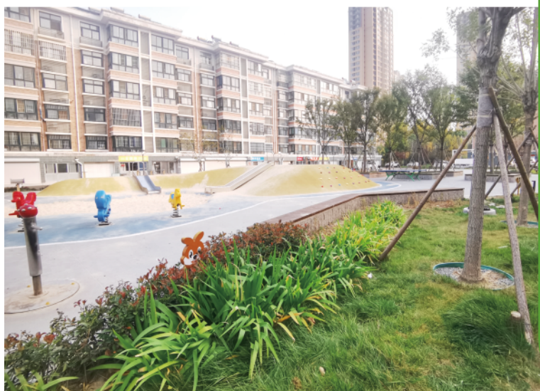
奎文区梨园小区进行海绵城市改造,效果非常显著。
