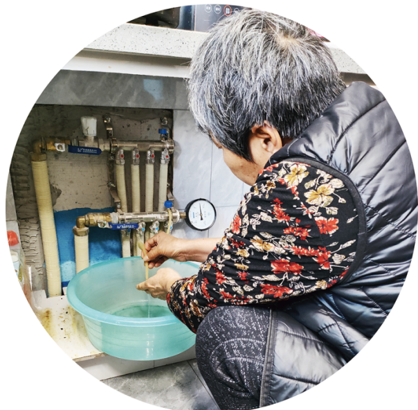
居民正给地暖分水器排气。
