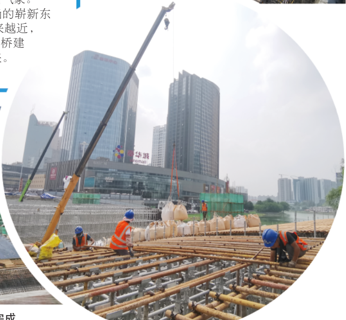
7月26日, 施工人员紧锣密鼓安装满堂支架。
