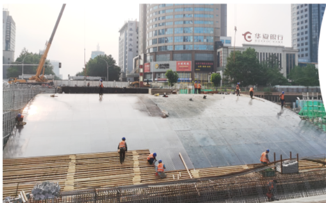
8月15日, 白浪东风桥满堂支架全部安装完成。
