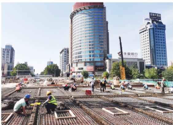
10月1日, 挂梁在进行钢筋绑扎和模板支设。
