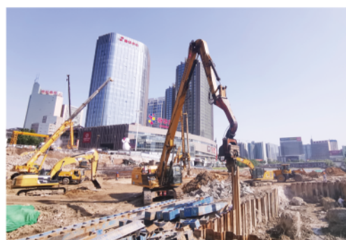
▲5月15日, 白浪东风桥桩基施工全速推进。
