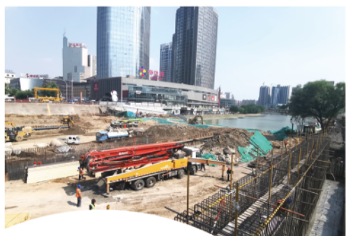
▼5月31日, 112根桩基施工全部完成。
