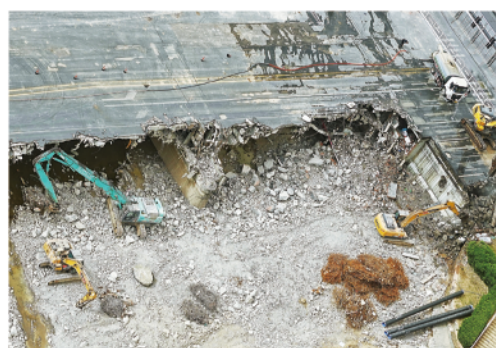
4月11日, 从空中俯拍的旧桥拆除场景。
