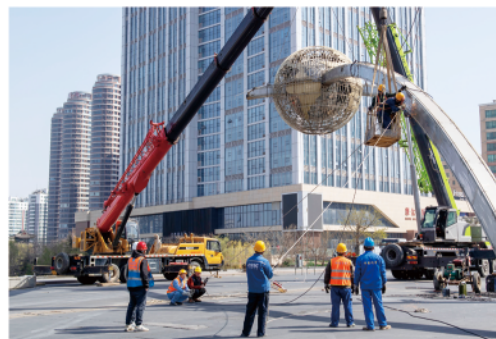
3月25日, 施工人员拆除亚星桥上的标志性建筑“星球”雕塑。
