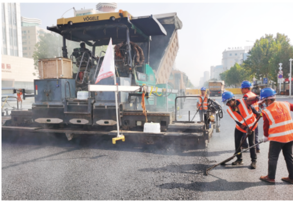
10月25日,白浪河东风桥开始进行桥面沥青铺设。
