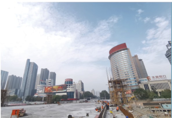
10月18日,桥面铺装完成。
