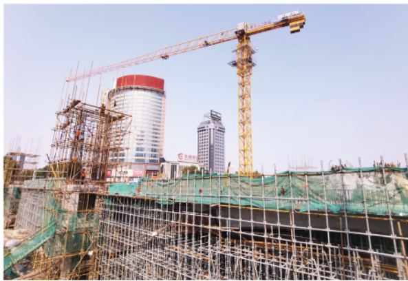
10月8日,白浪河东风桥挂梁浇筑施工全部完成。
