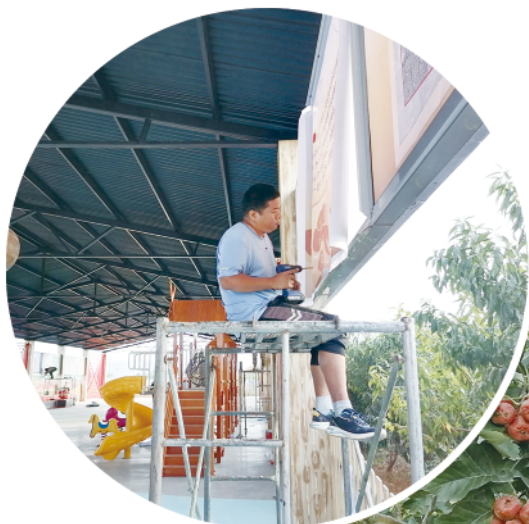
▲共富工坊正加紧施工。 ▶村民采摘山楂。
