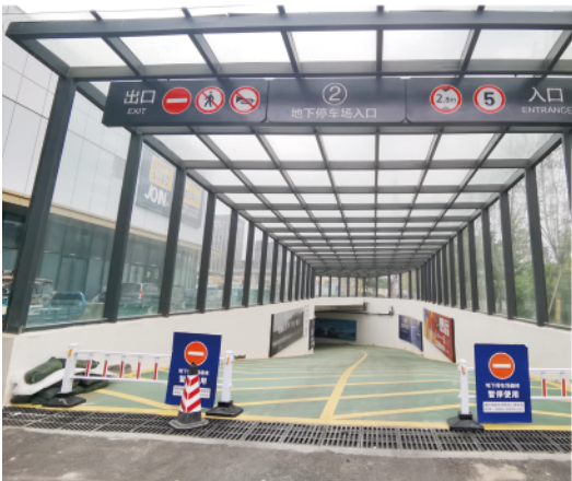
北辰谷德茂设置了多个地下停车场出入口。
