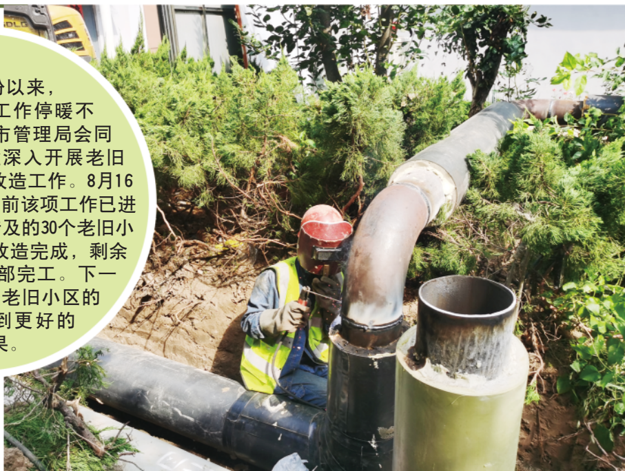
潍坊市热力有限公司的维修人员在对供热设施进行改造提升。
