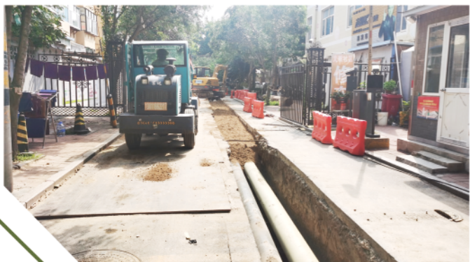
在奎文区公安巷,潍坊市热力有限公司在改造供热管网。
