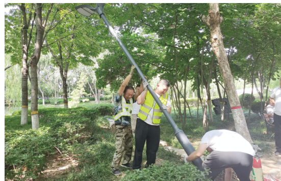
施工人员安装路灯。
