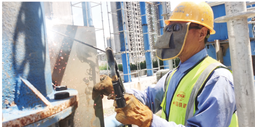
施工人员在焊接盘扣支架。
