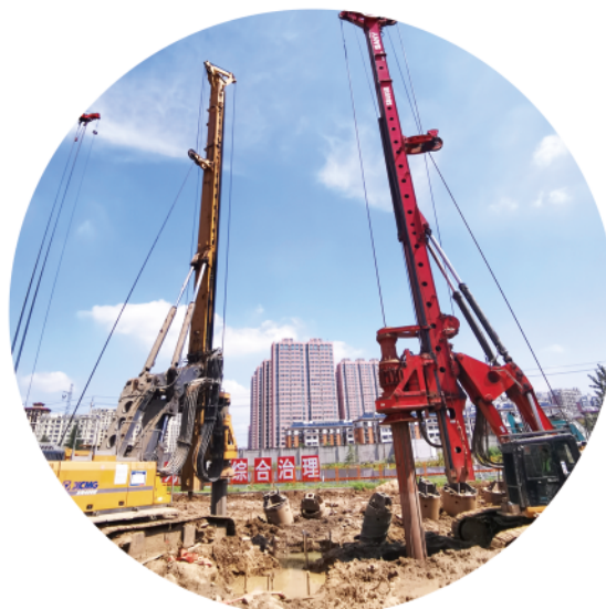
涉铁段进行桩基施工。
